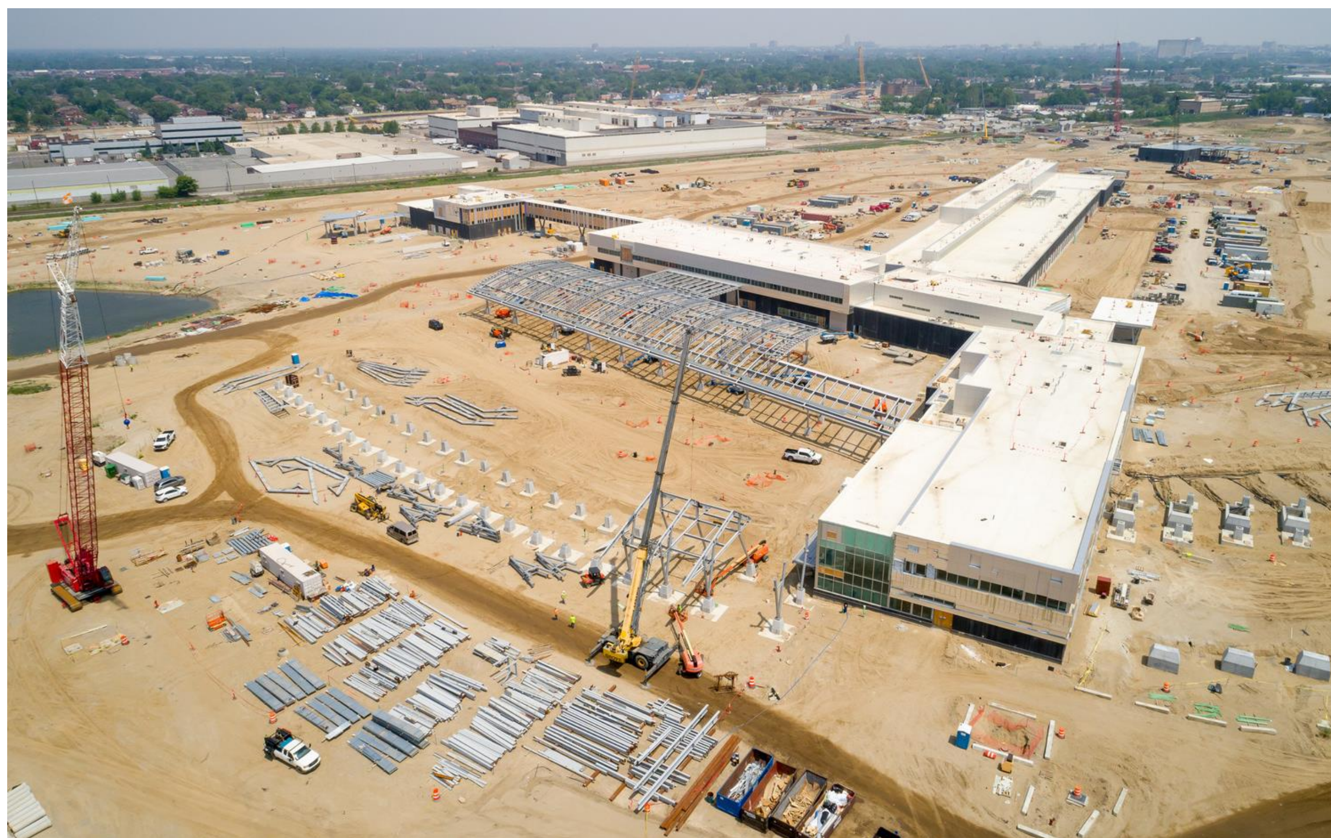
Progrès de la construction au point d'entrée américain
