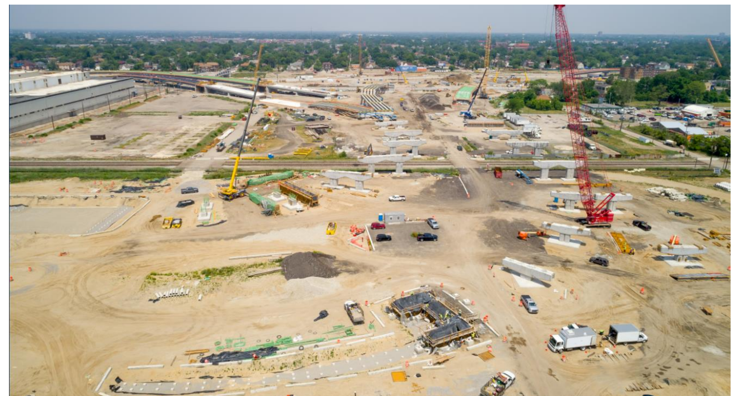
Progrès de la construction au point d'entrée américain
