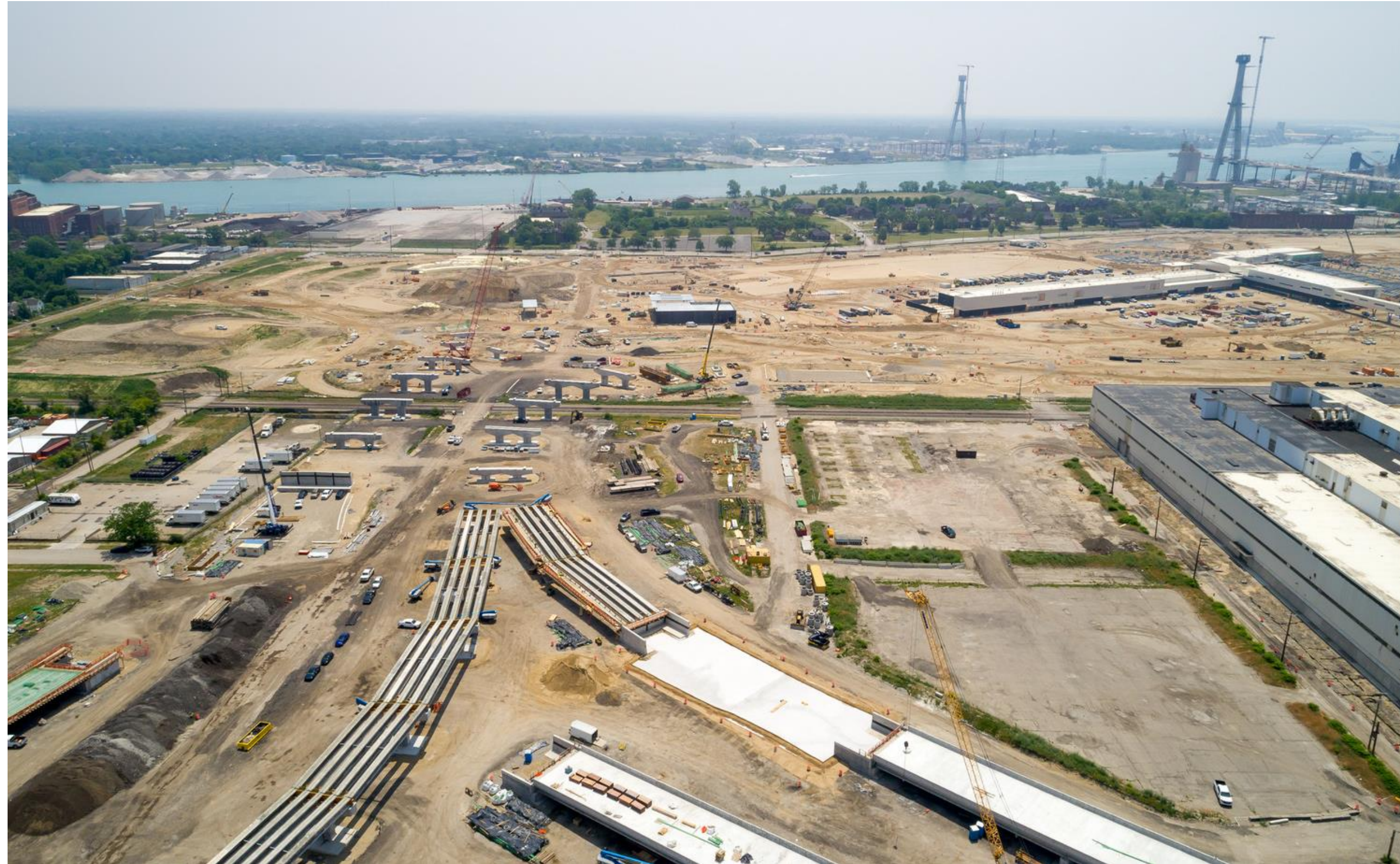
Progrès de la construction au point d'entrée américain
