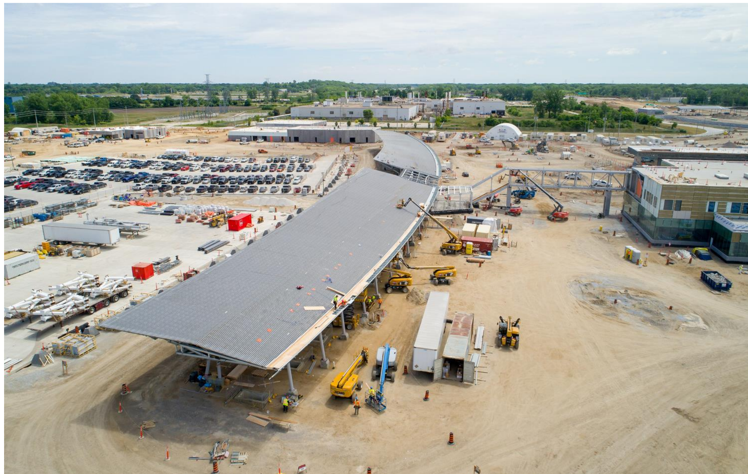
Construction de l'auvent de la voie d'inspection primaire du point d'entrée canadien
