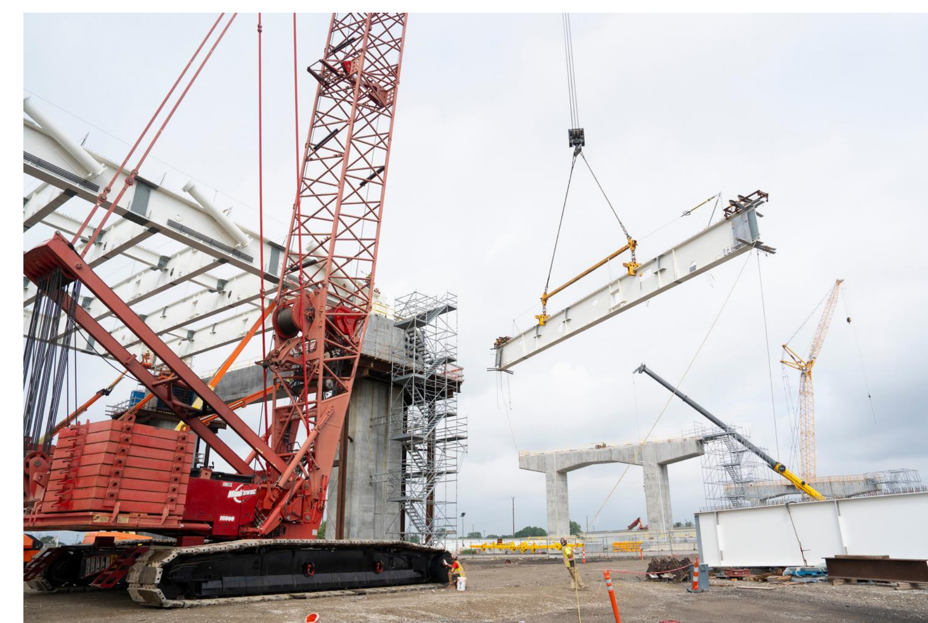
Progression du chantier du pont américain (photo de gauche) et installation d'une poutre du tablier (photo de droite)
