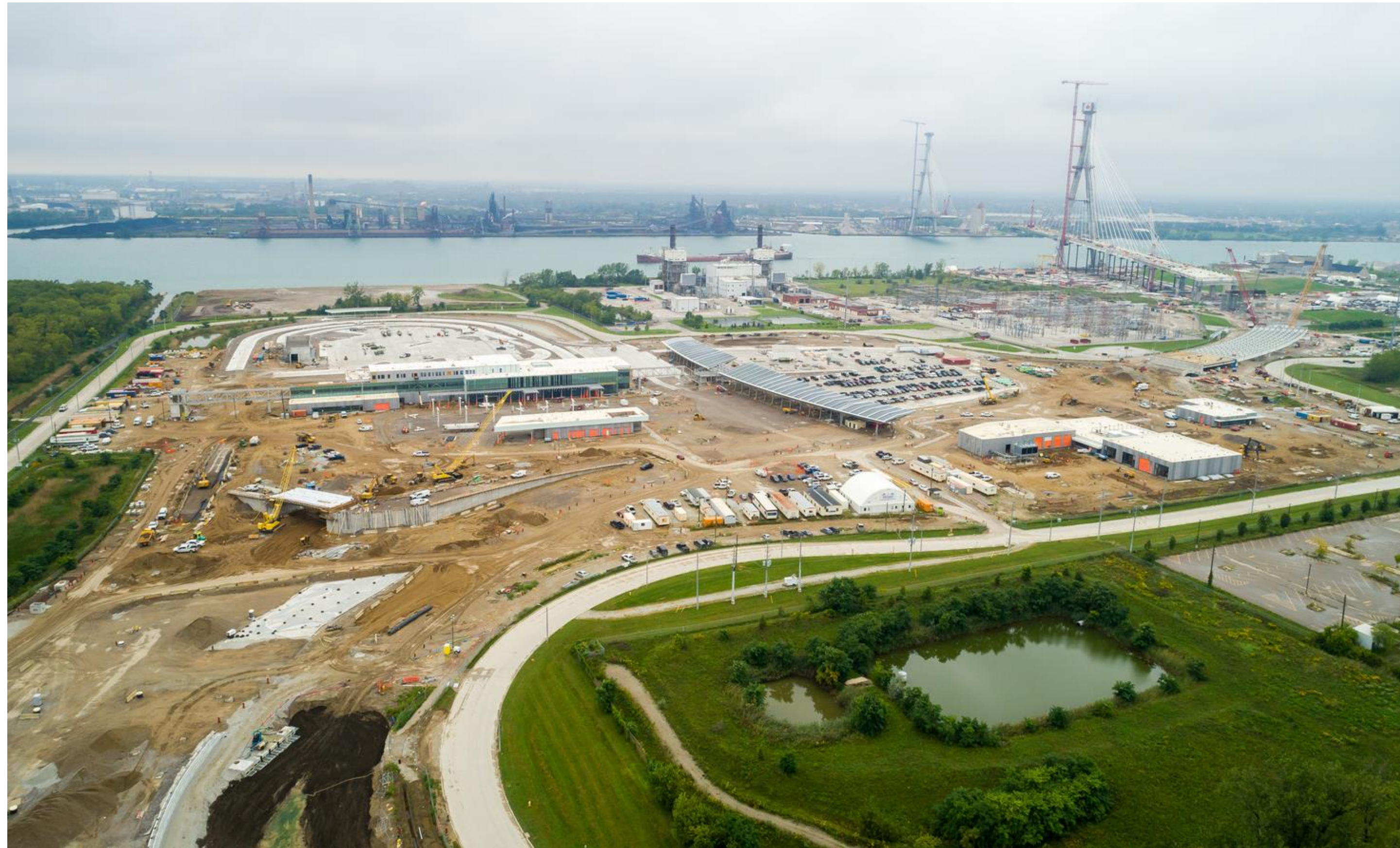
Progrès de la construction au point d'entrée canadien
