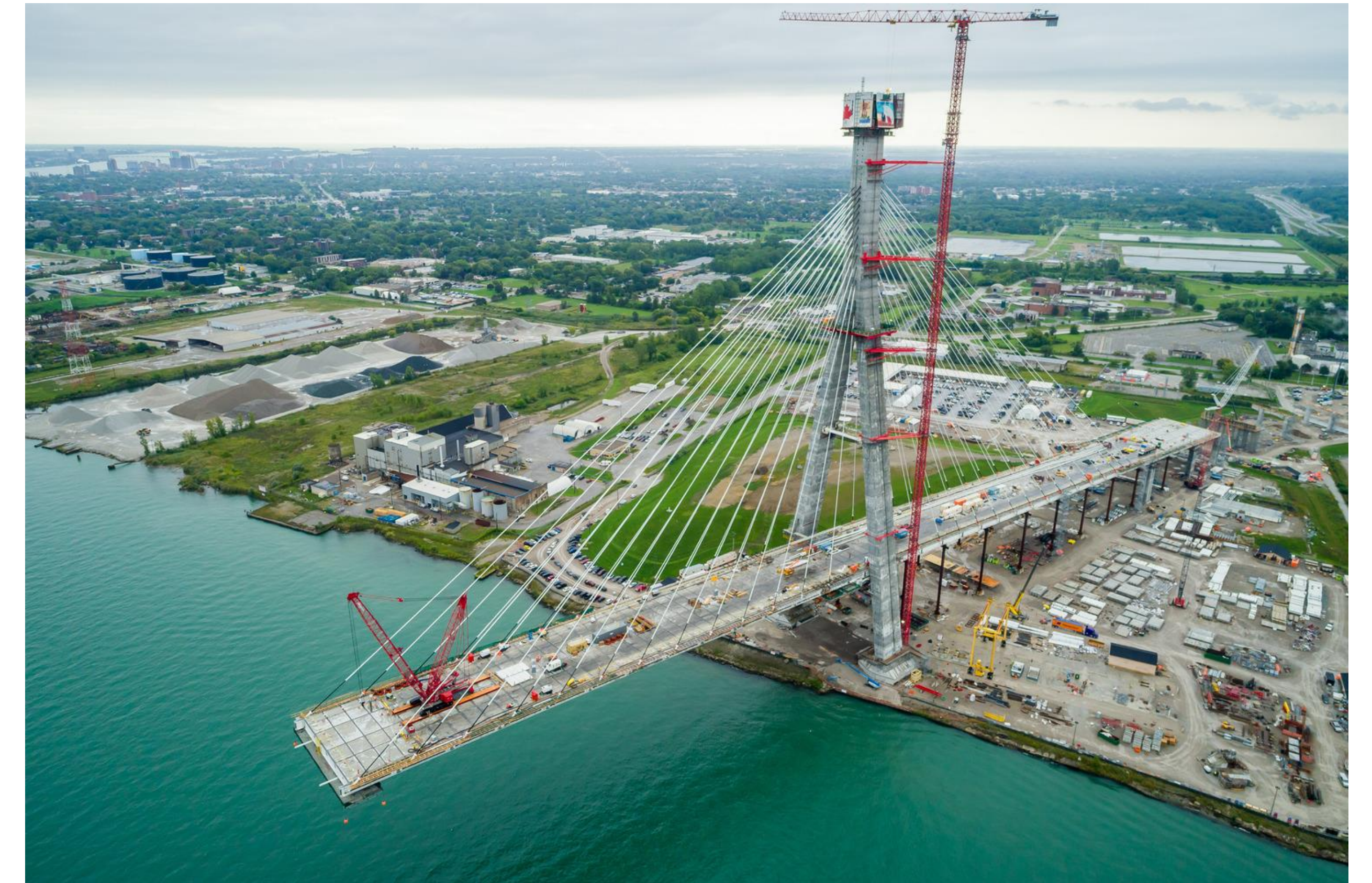
Progression du chantier du pont canadien
