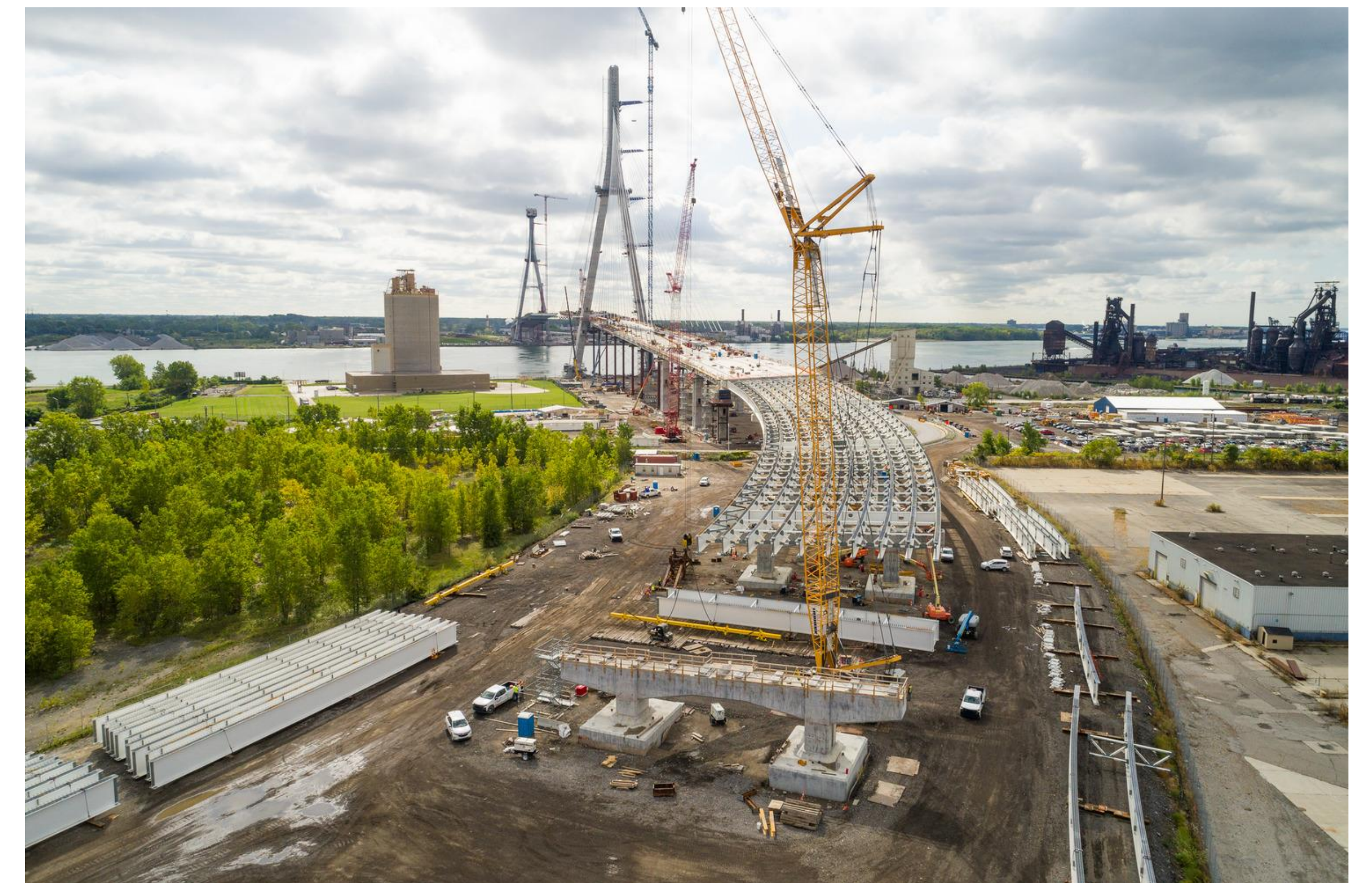
Progression du chantier du pont américain
