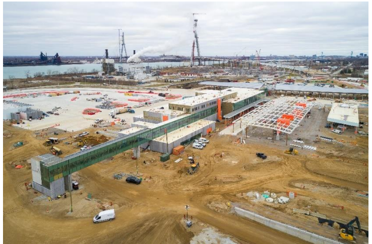
Progrès de la construction au point d'entrée canadien
