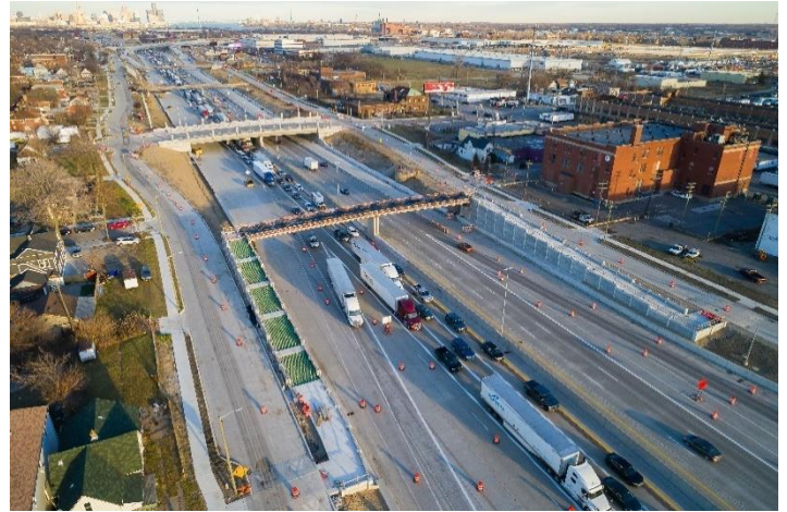
Construction de la passerelle pour piétons de la rue
