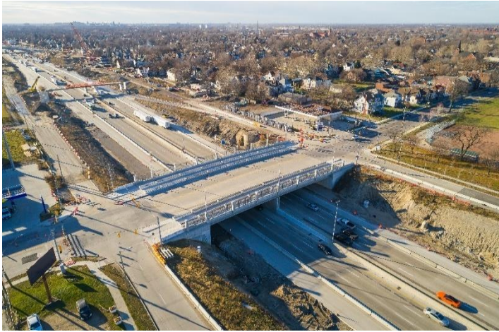
Pont routier de la rue Clark
