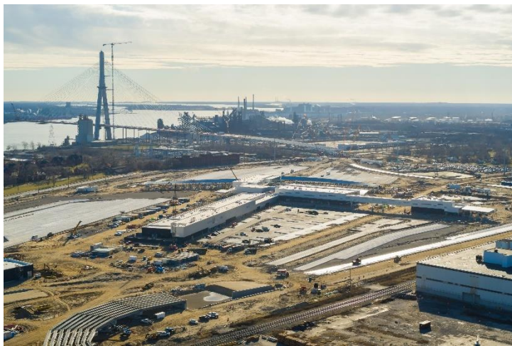
Progrès de la construction au point d'entrée américain
