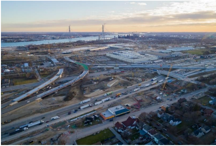
Progrès de la construction des bretelles de raccordement à l'I-75 et au PDE américain
