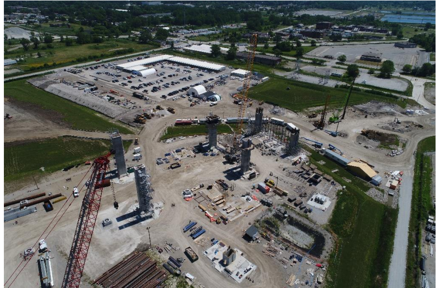
Vue des piliers de la travée latérale et des piliers d'ancrage sur le site du pont canadien.
