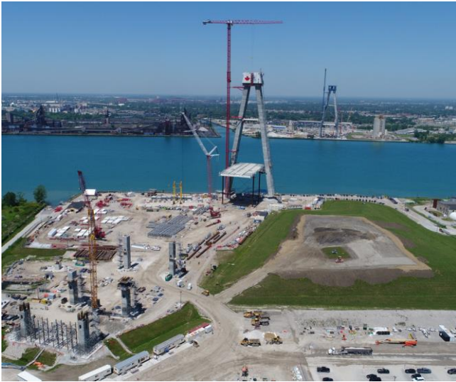
Construction de tabliers et de travées latérales du pont au Canada
