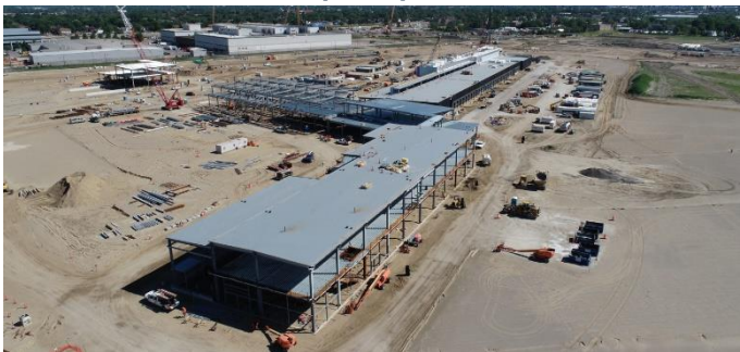
Construction des installations du point d'entrée
