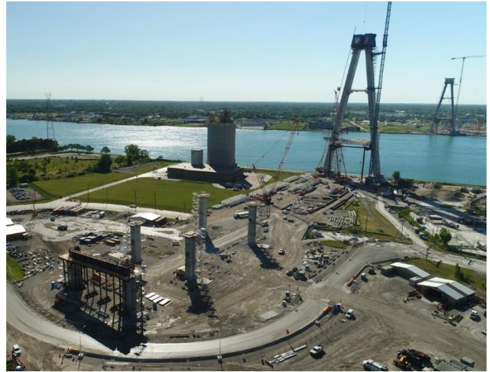
Construction du pont aux États-Unis
