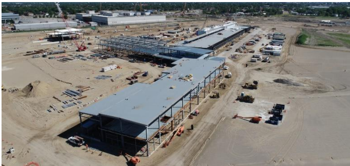
Construcción de las instalaciones en el Punto de entrada estadounidense
