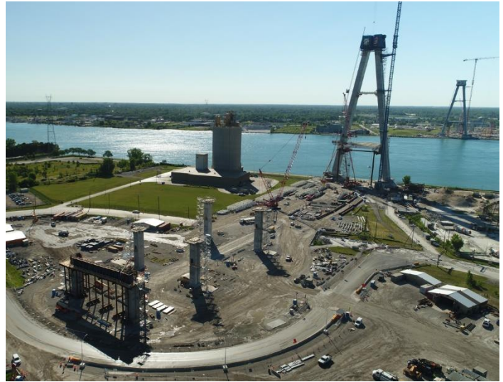
Construcción del puente en E.E. U.U.
