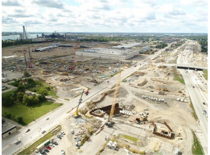
Construcción de las rampas en la I-75
