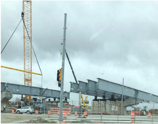
Trabajo de instalación de las vigas
