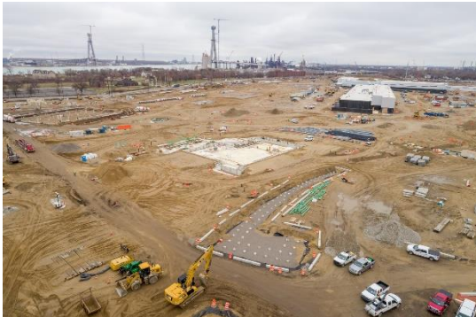
Construcción en el Punto de entrada estadounidense
