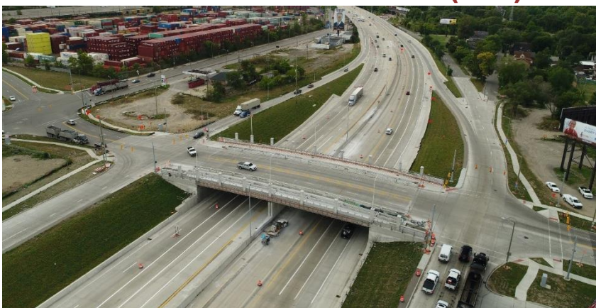
Puente vial de Springwells Street
