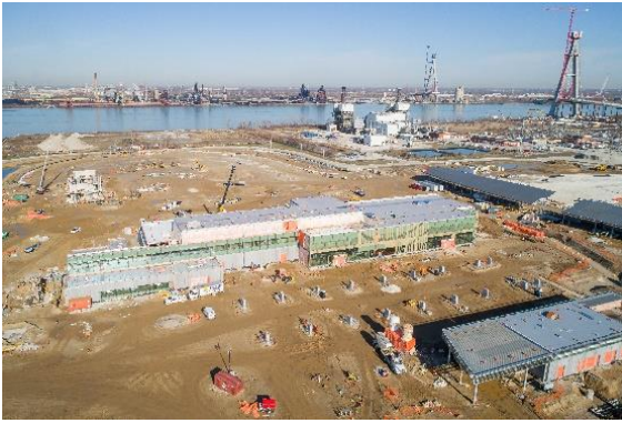
Construcción del Punto de entrada canadiense
