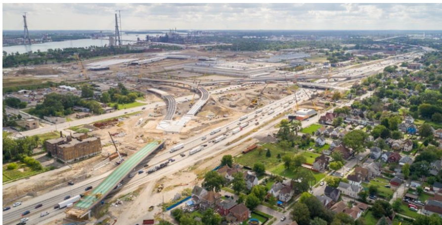
Travaux sur l'échangeur du michigan
