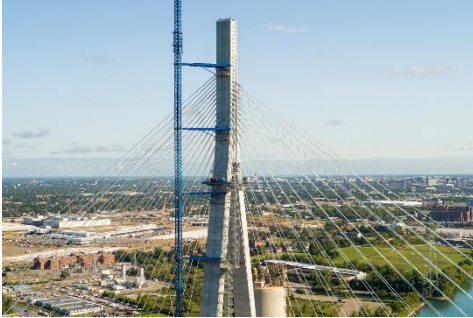
Construction de la tour américaine (en haut) et construction de la tour canadienne (en bas).
