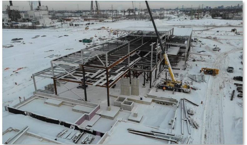
Poursuite de la construction de bâtiments en hiver au point d'entrée
