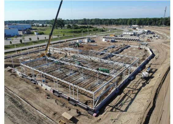
Construcción de edificios en el Punto de entrada canadiense
