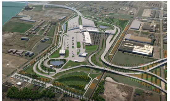
Futuras rampas de la I-75 que se conectarán con el Punto de entrada estadounidense
