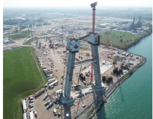
Trabajo en la torre del puente en Canadá
