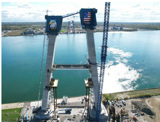
Trabajo en la torre del Puente en estados Unidos
