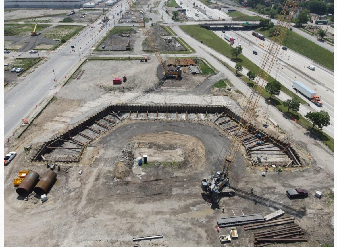
Site américain du pont Construction du siphon de la rue Cavalry
