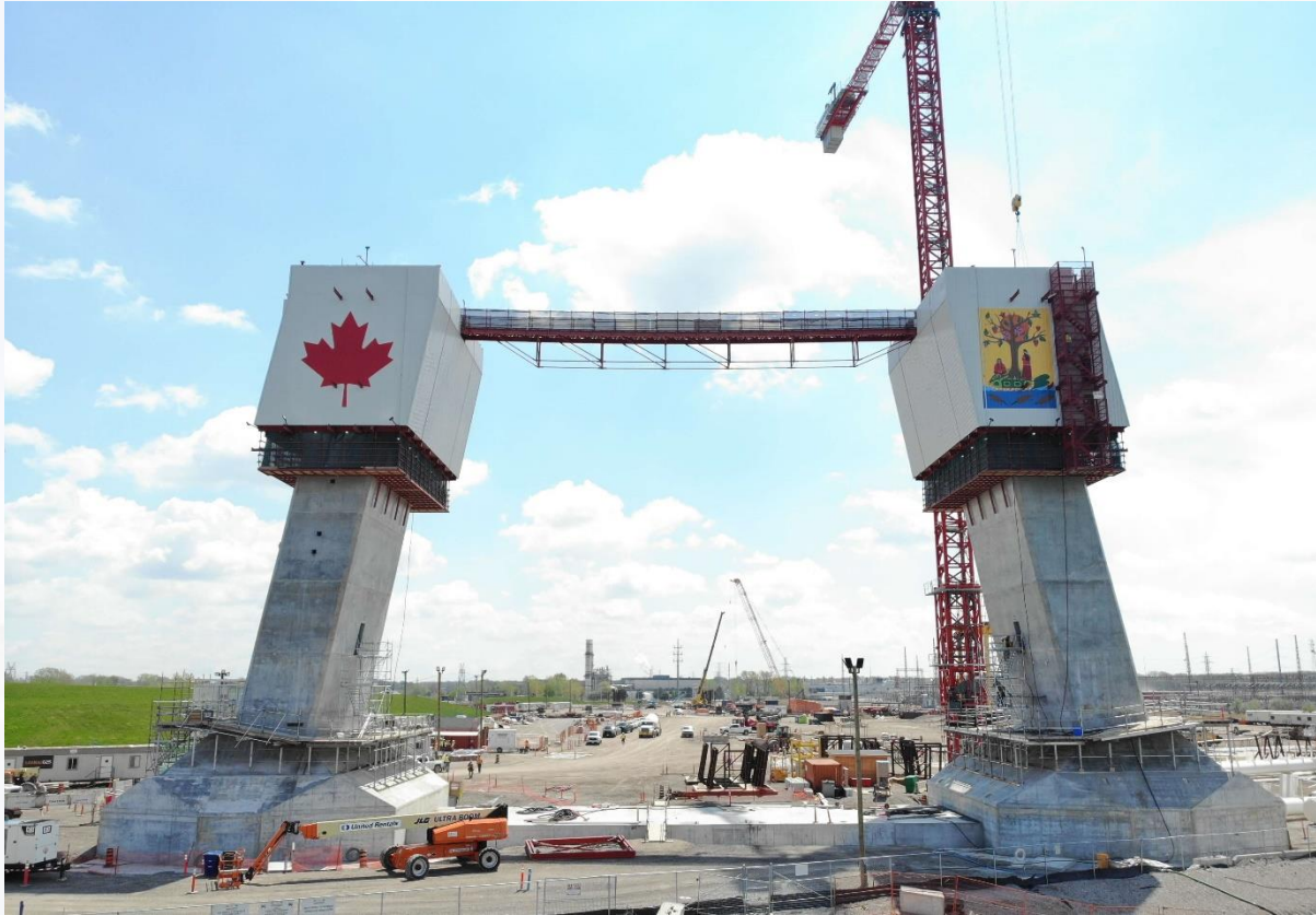
Travaux sur la tour du pont au Canada
