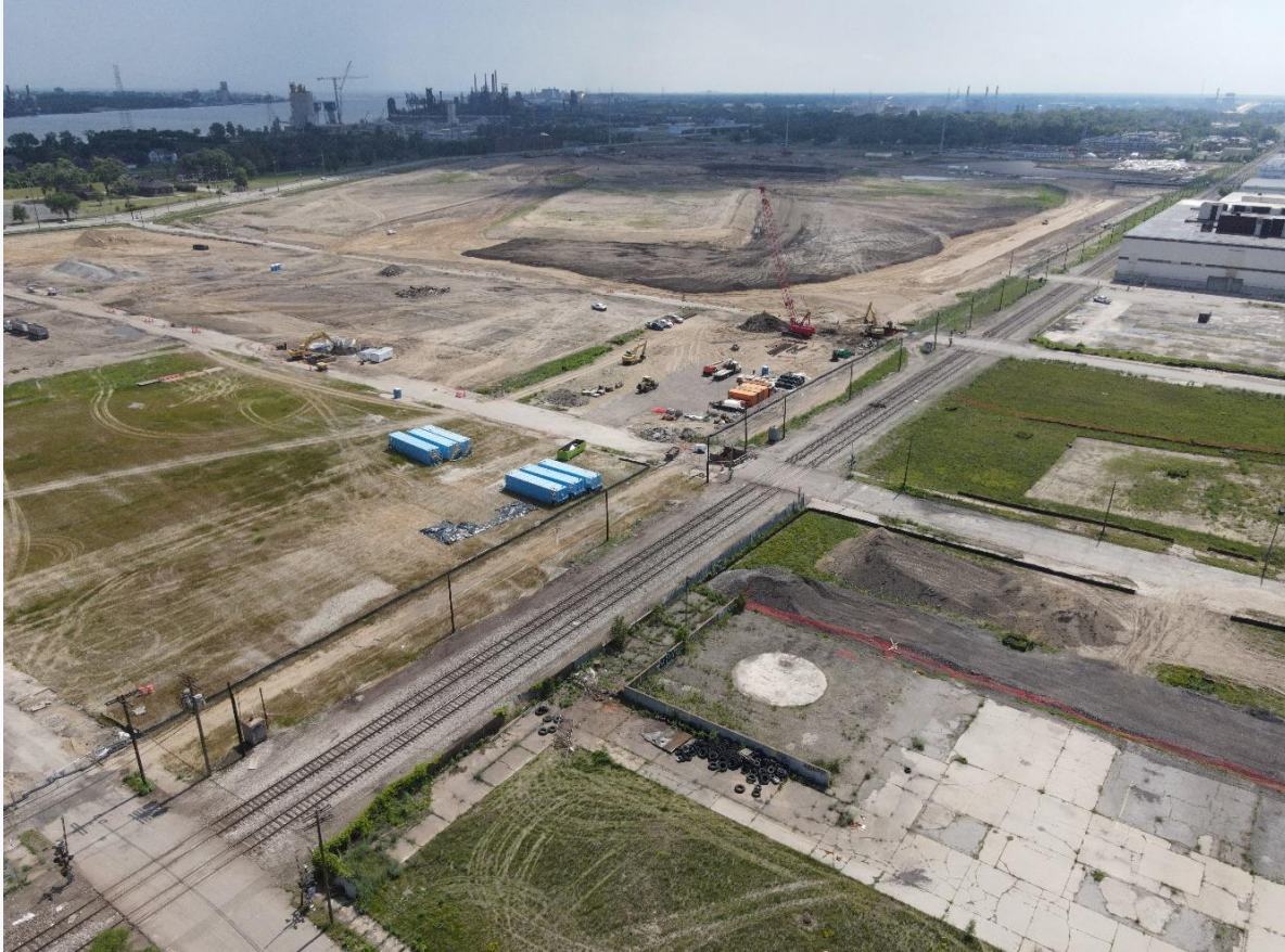
Travaux de terrassement au PDE américain
