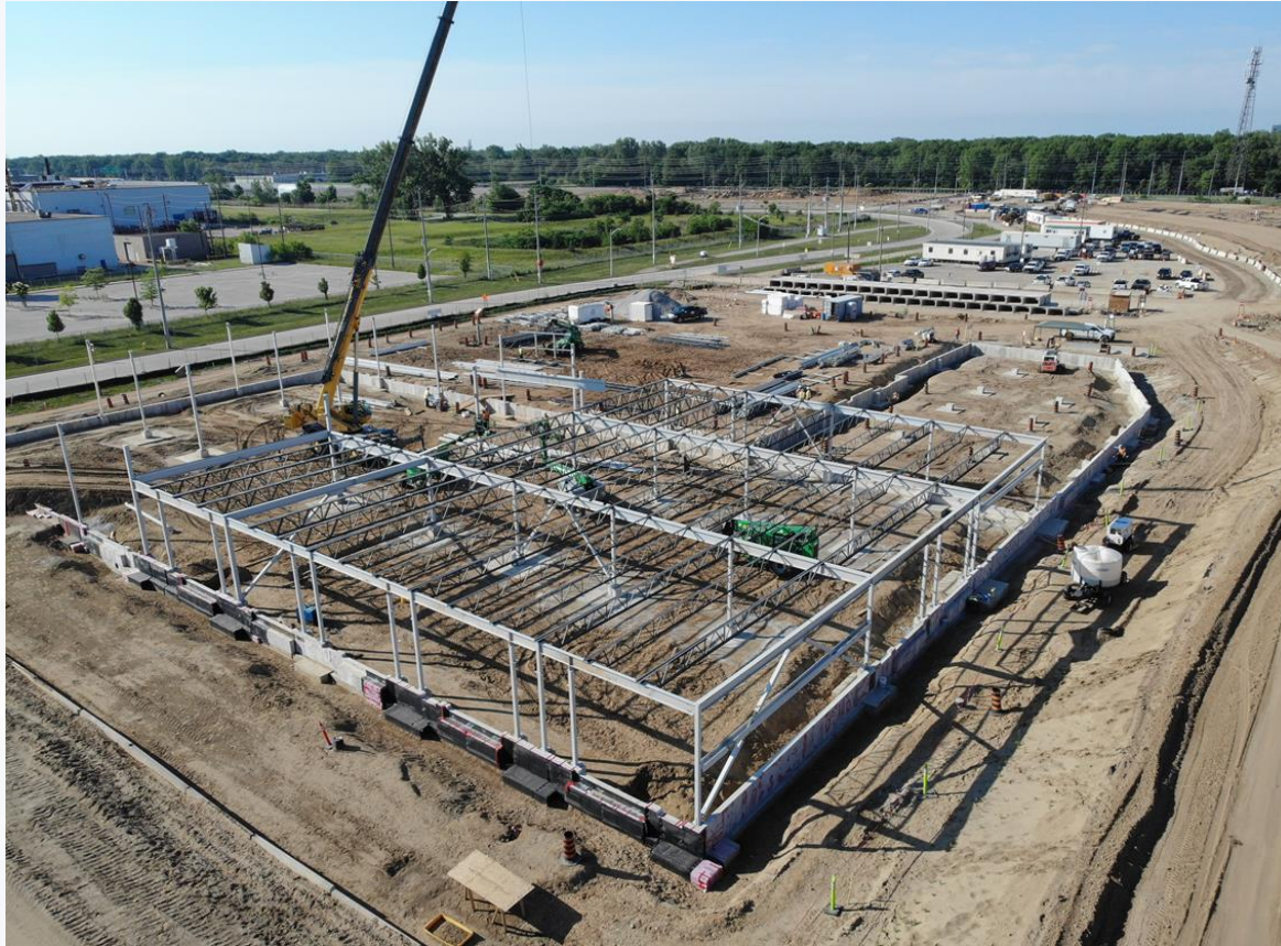
Construction des bâtiments du PDE canadien
