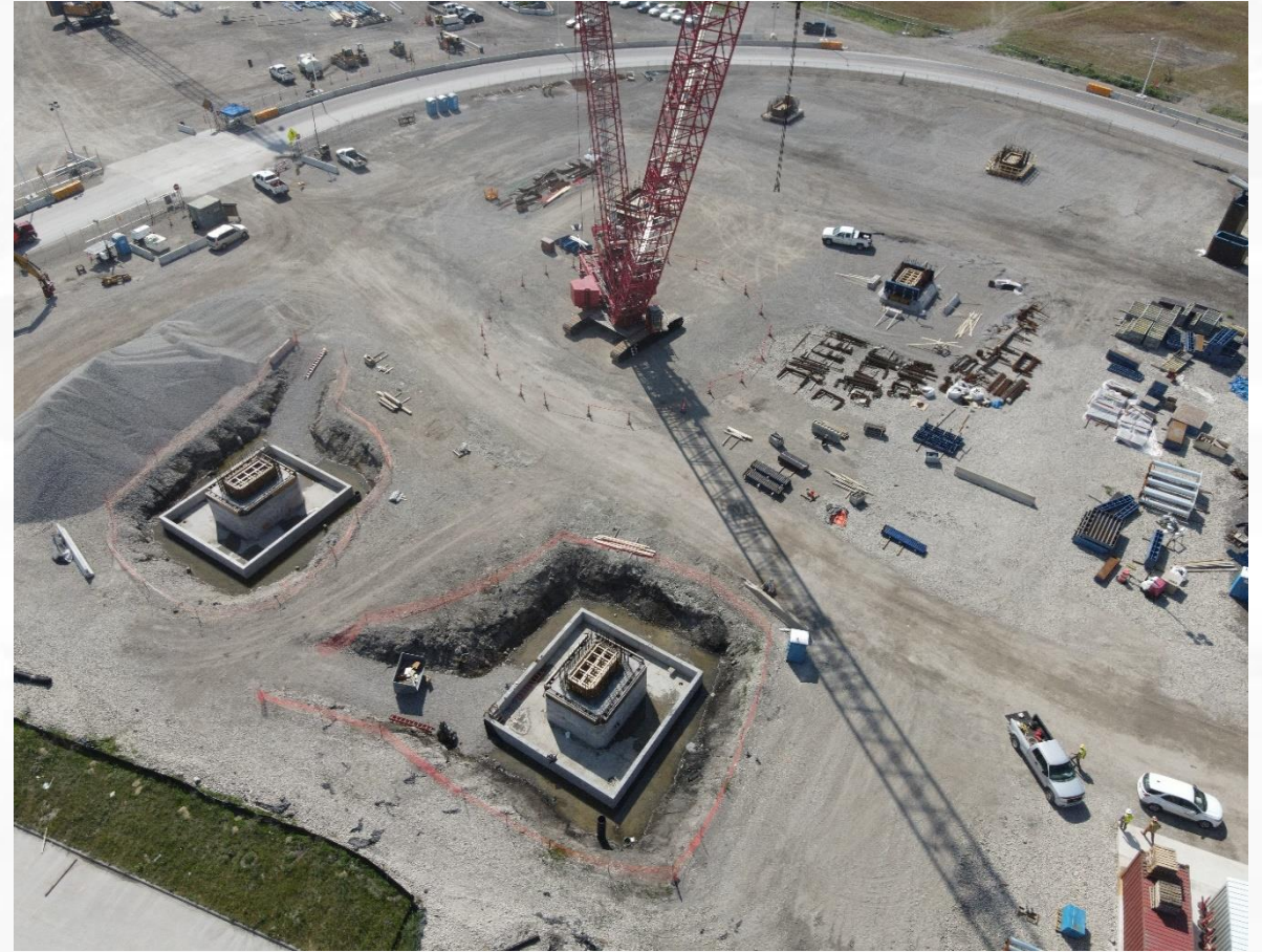
Travaux sur la travée arrière du pont aux États-Unis
