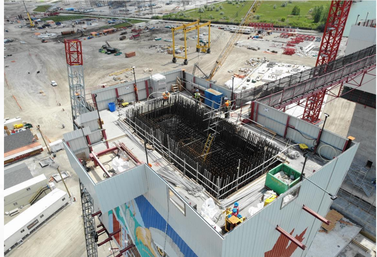
Travaux sur la tour du pont au Canada
