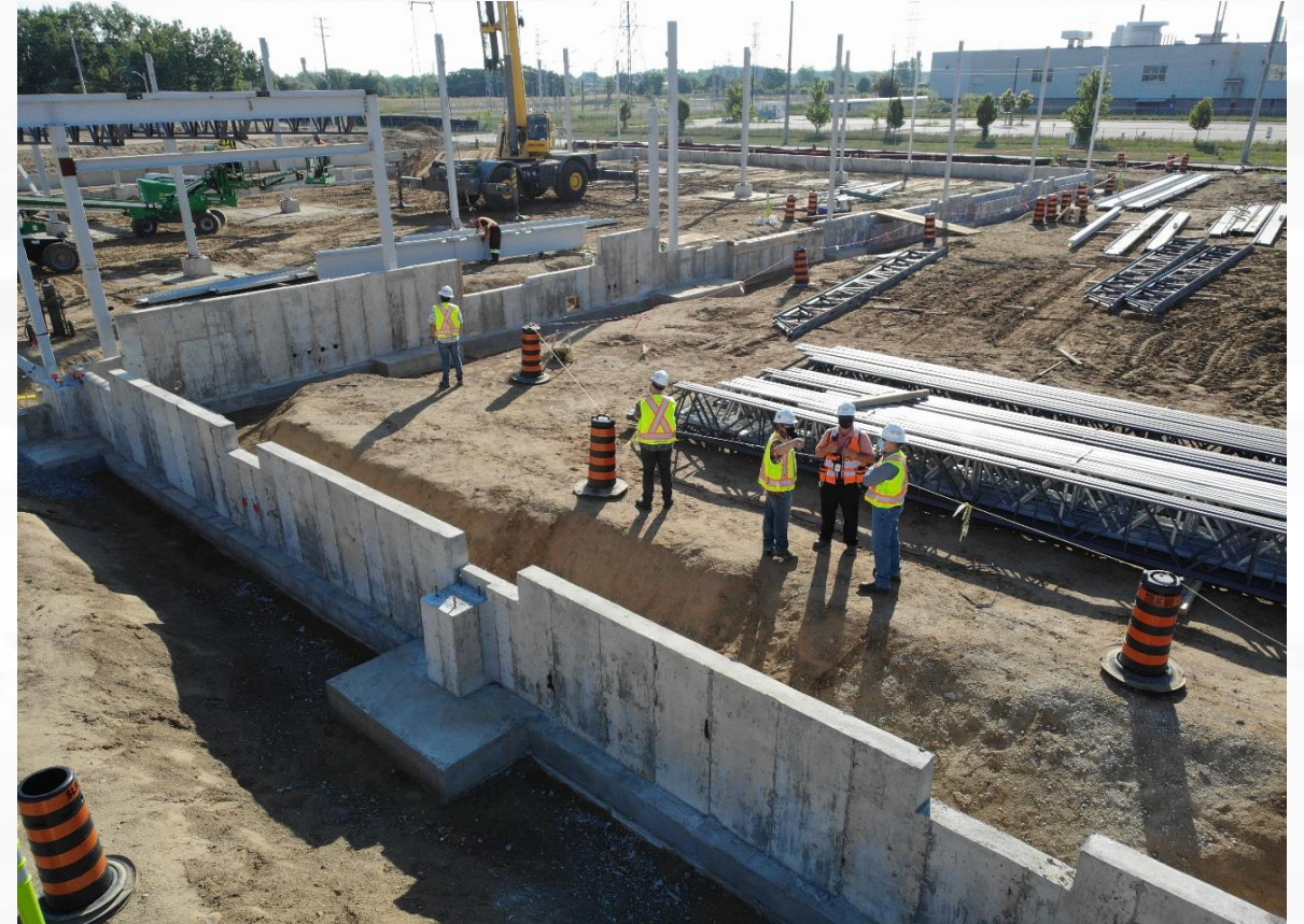
Construction du bâtiment au PDE américain
