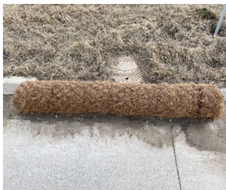
Une bûche de coco positionnée devant le système de drainage
