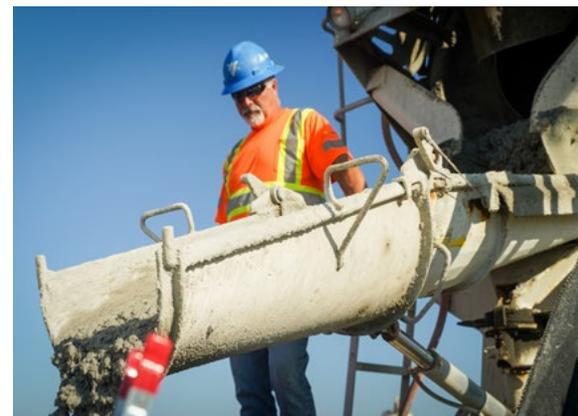
Vertido de concreto para los cimientos de la torre en el emplazamiento del puente canadiense
